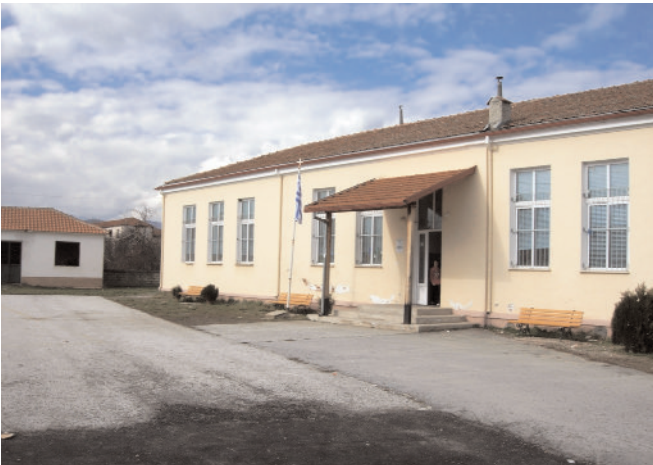
Το κτίριο του Δημοτικού Σχολείου Περάσματος Ν. Φλώρινας.
